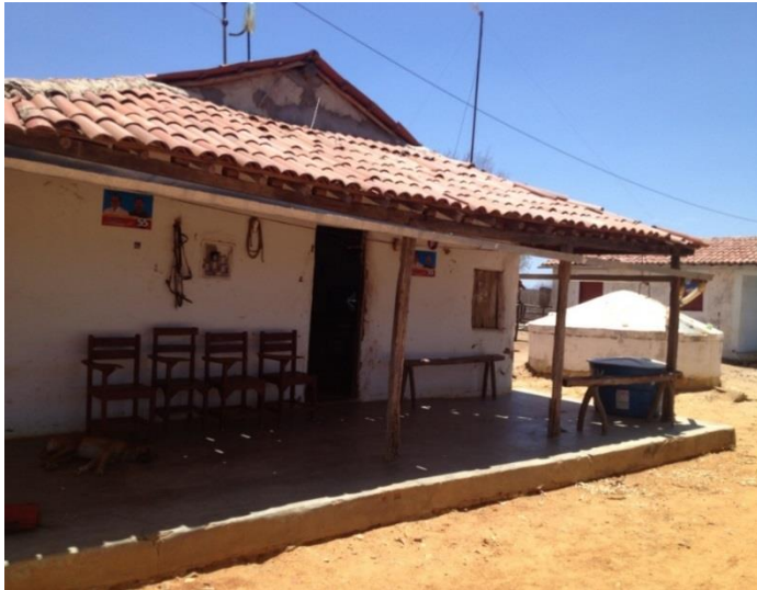
Foto 02 – Casas com Cisternas
