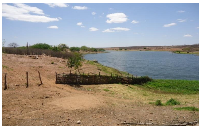
Foto 04 – Barragem do Frazão
