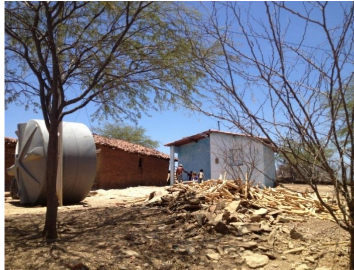
Foto 03 – Casas com Cisternas
