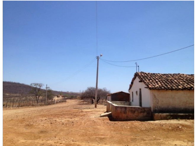
Foto 07 - Ruas Sem Pavimentações
