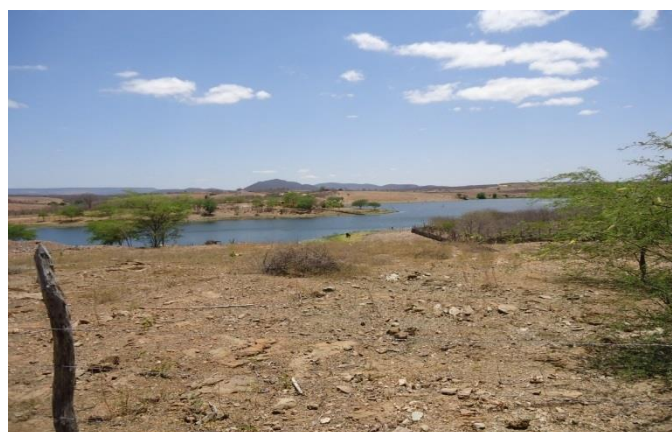
Foto 05 - Barragem do Frazão
