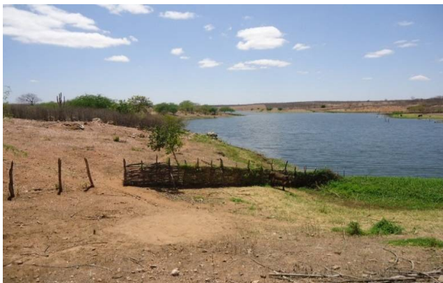
Foto 04 - Barragem do Frazão
