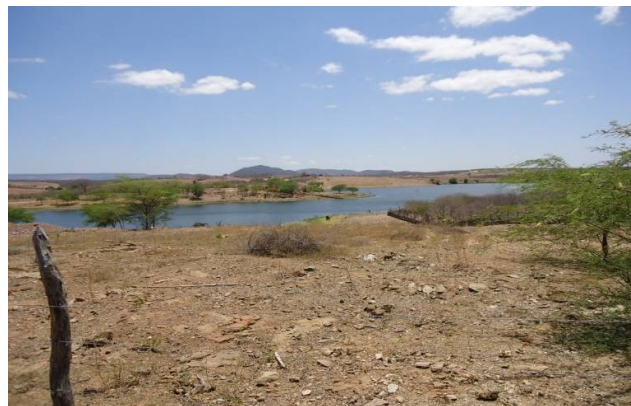
Foto 05 - Barragem do Frazão
